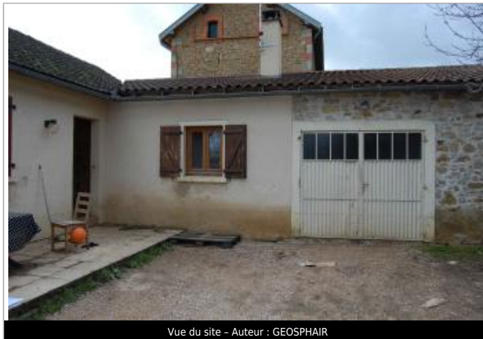
Vue du site - Auteur : GEOSPHAIR
