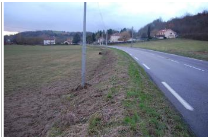
Vue du site - Auteur : GEOSPHAIR
