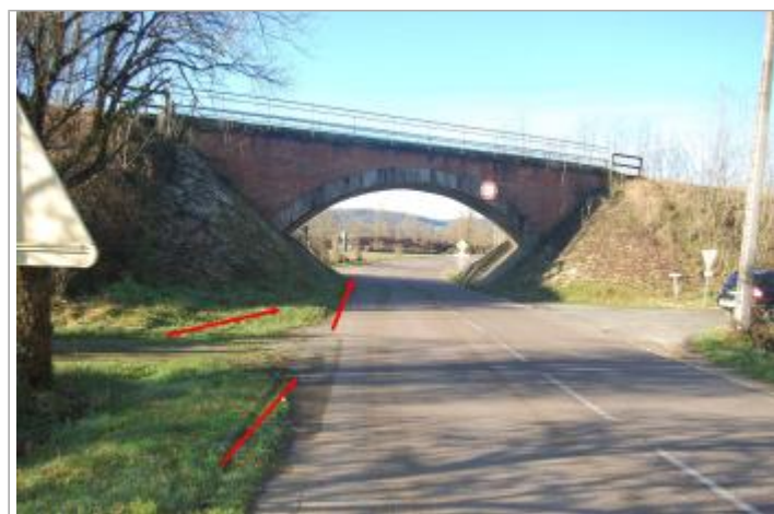
Vue du site - Auteur : GEOSPHAIR
