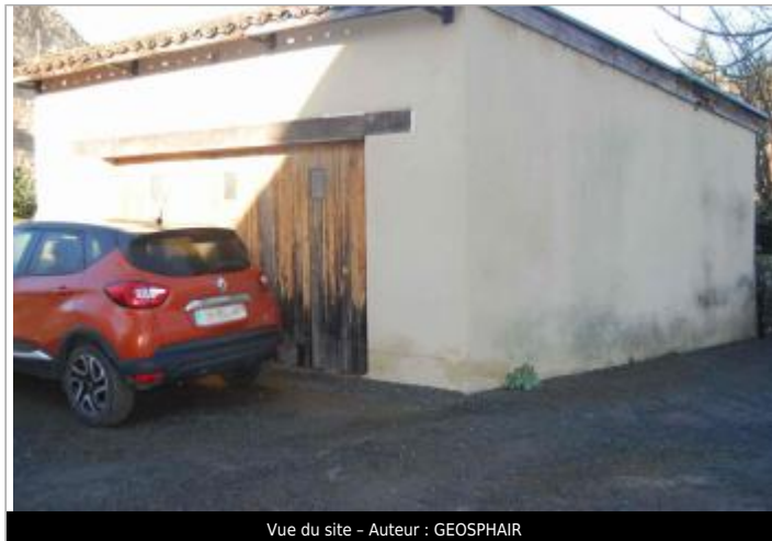
Vue du site - Auteur : GEOSPHAIR
