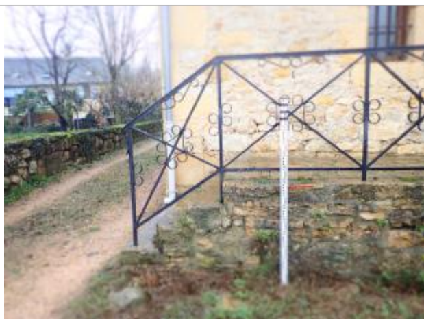
Vue de la laisse d'inondation - Auteur : Syndicat du Bassin de la Rance et du Célé
