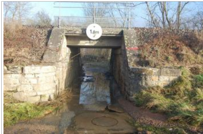
Vue du site - Auteur : GEOSPHAIR
