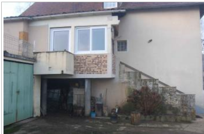
Vue du site - Auteur : GEOSPHAIR
