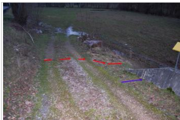
Vue du site - Auteur : GEOSPHAIR
