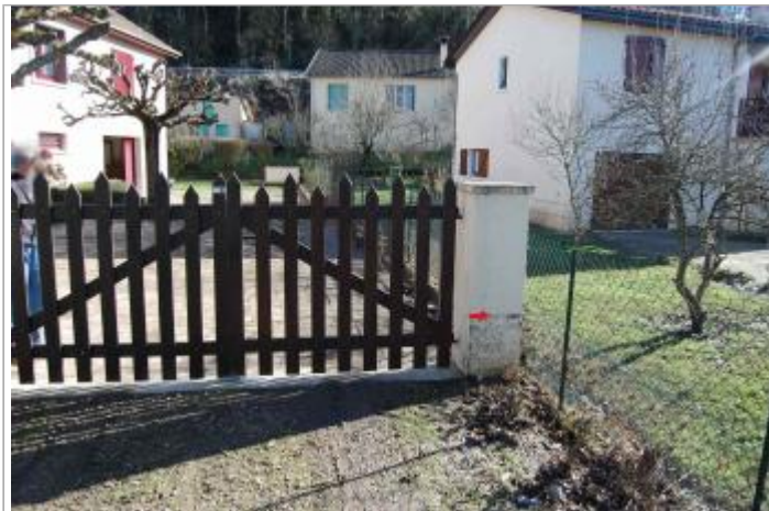
Vue du site - Auteur : GEOSPHAIR
