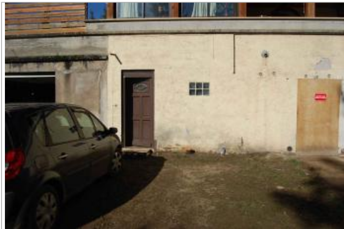
Vue du site - Auteur : GEOSPHAIR
