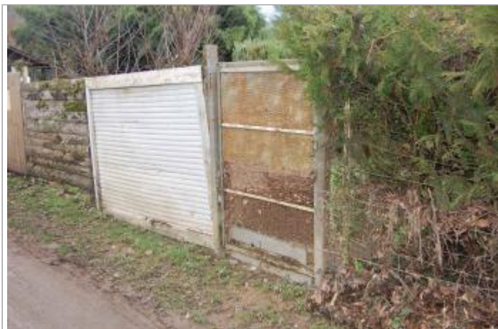
Vue du site - Auteur : GEOSPHAIR
