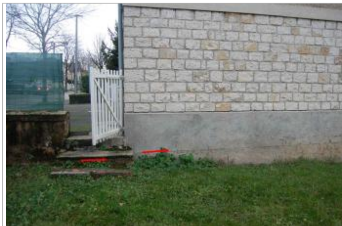
Vue du site - Auteur : GEOSPHAIR
