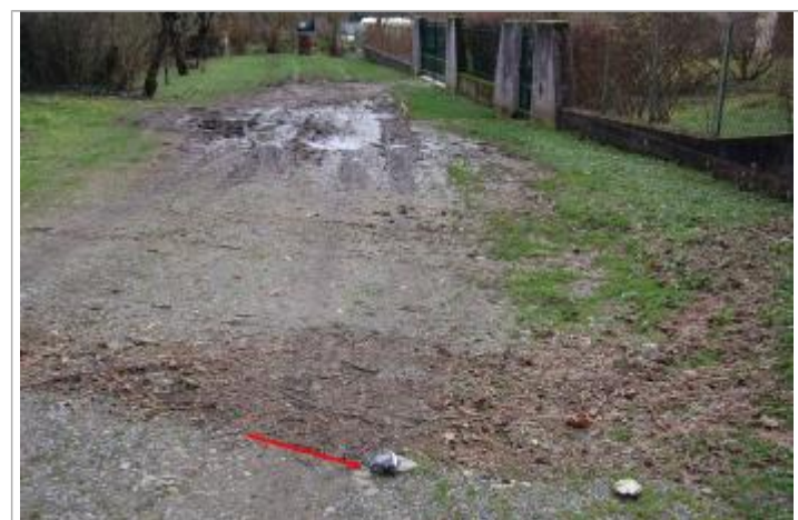
Vue de la laisse d'inondation - Auteur : GEOSPHAIR
