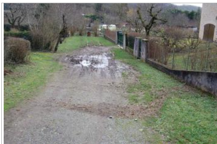
Vue du site - Auteur : GEOSPHAIR
