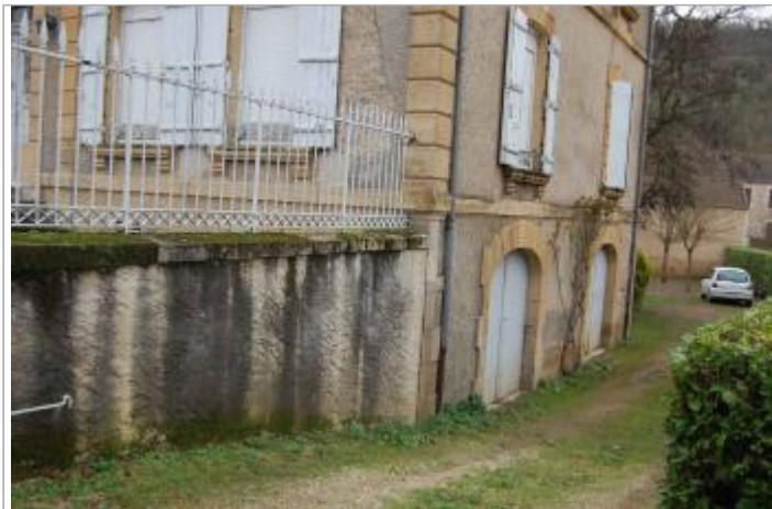
Vue du site - Auteur : GEOSPHAIR
