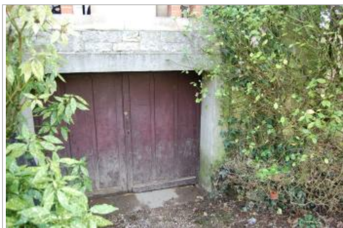
Vue du site - Auteur : GEOSPHAIR
