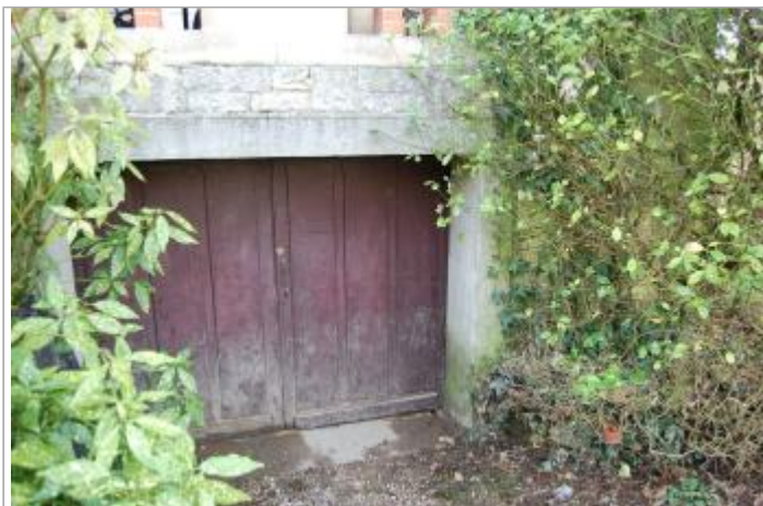
Vue du site - Auteur : GEOSPHAIR
