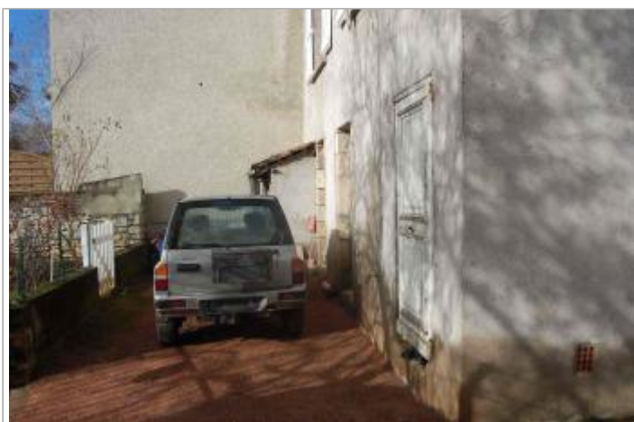
Vue du site - Auteur : GEOSPHAIR
