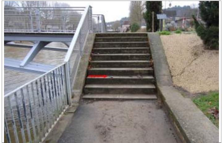
Vue du site - Auteur : GEOSPHAIR
