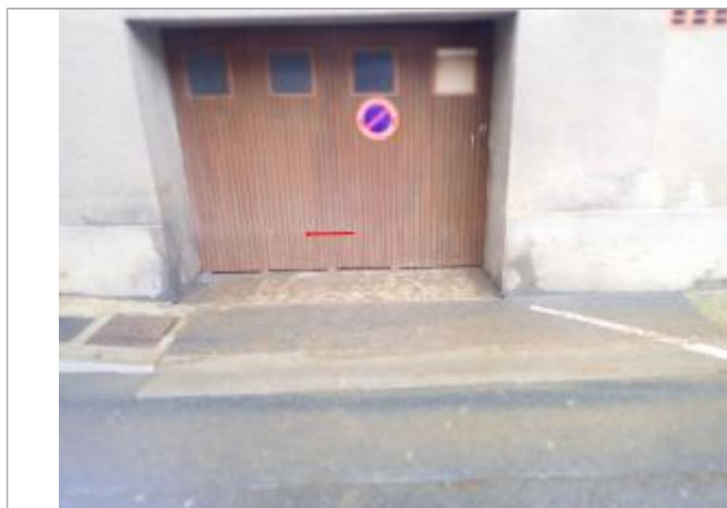
Vue de la laisse d'inondation - Auteur : Syndicat du Bassin de la Rance et du Célé
