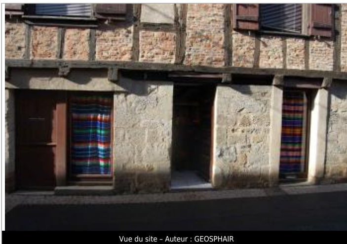
Vue du site - Auteur : GEOSPHAIR
