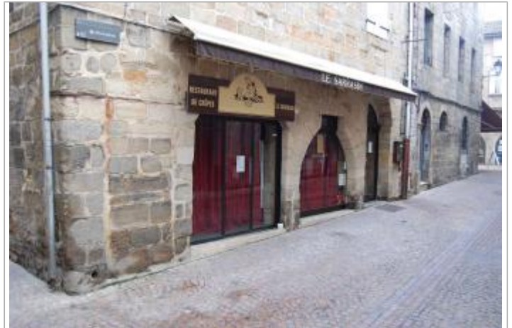
Vue du site - Auteur : GEOSPHAIR
