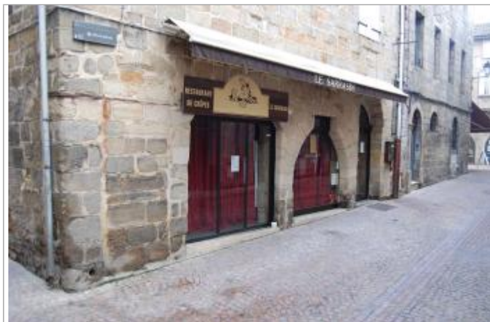
Vue du site - Auteur : GEOSPHAIR
