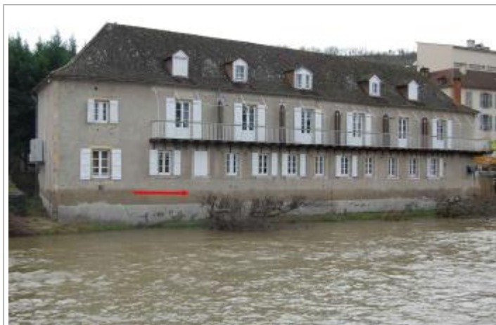
Vue du site - Auteur : GEOSPHAIR
