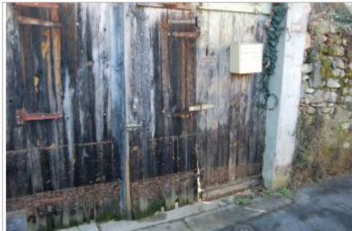
Vue du site - Auteur : GEOSPHAIR
