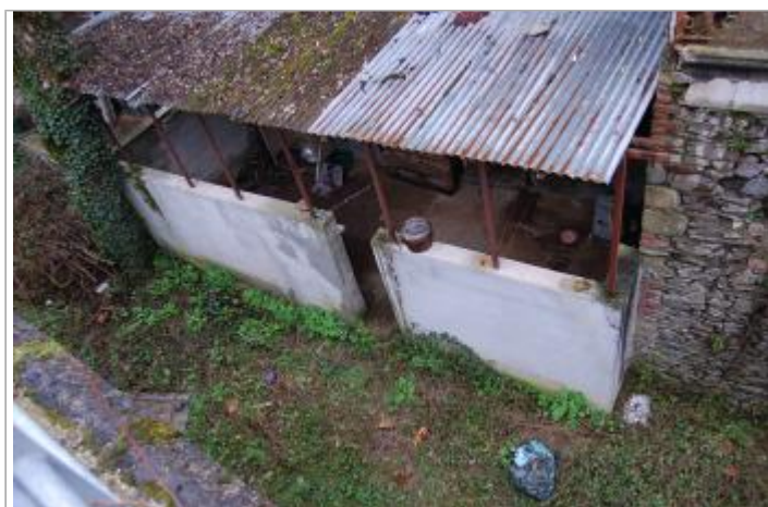
Vue du site - Auteur : GEOSPHAIR
