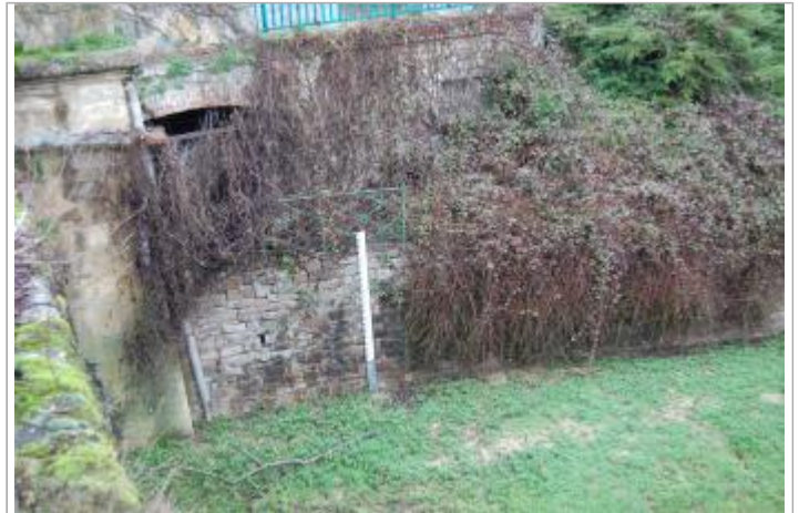
Vue du site - Auteur : GEOSPHAIR
