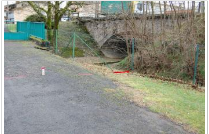
Vue du site - Auteur : GEOSPHAIR
