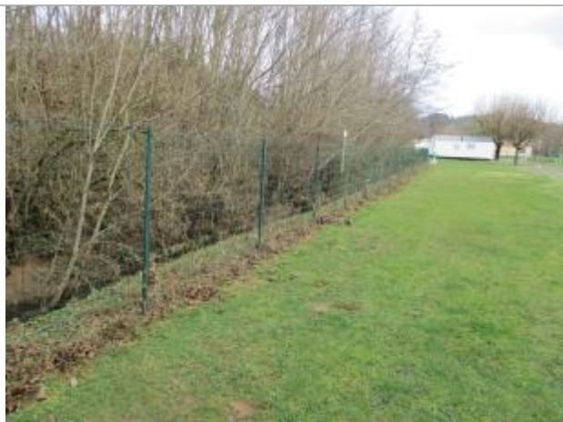
Vue de la laisse d'inondation - Auteur : DDT46
