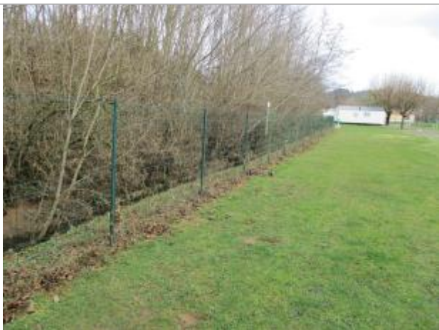
Vue de la laisse d'inondation - Auteur : DDT46
