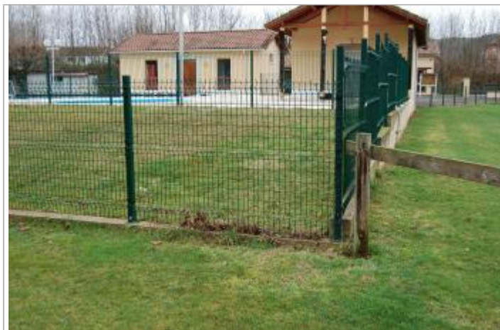
Vue du site - Auteur : GEOSPHAIR
