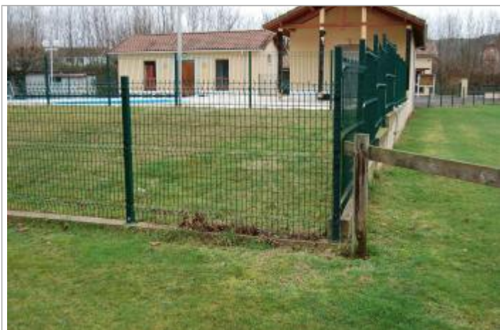
Vue de la laisse d'inondation - Auteur : GEOSPHAIR
