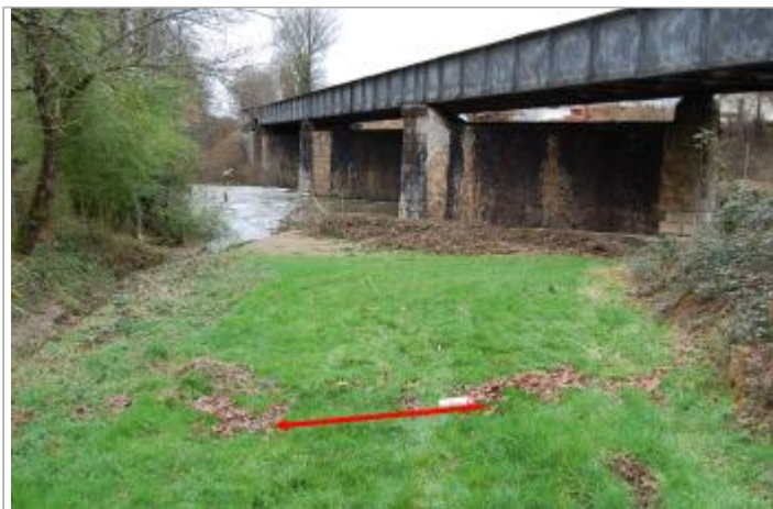
Vue du site - Auteur : GEOSPHAIR
