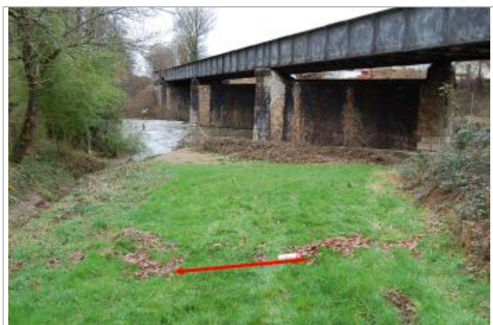
Vue de la laisse d'inondation - Auteur : GEOSPHAIR
