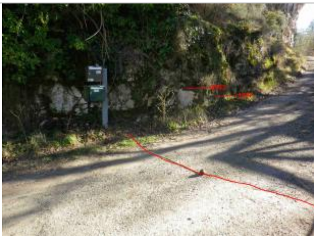
Vue de la laisse d'inondation - Auteur : GEOSPHAIR
