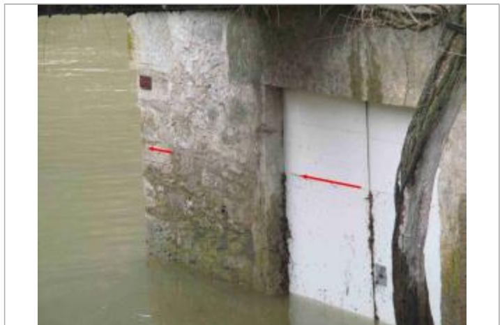
Vue de la laisse d'inondation - Auteur : DDT46
