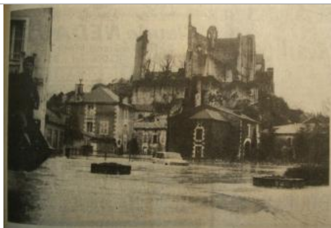
Crue du Talbat du 20 décembre 1982 - parking du jardin public / Credit photo : Centre-Press
