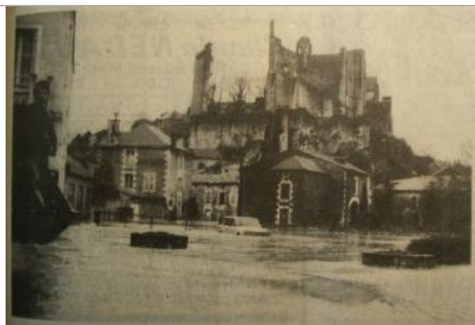
Crue du Talbat du 20 décembre 1982 - parking du jardin public / Credit photo : Centre-Presse
