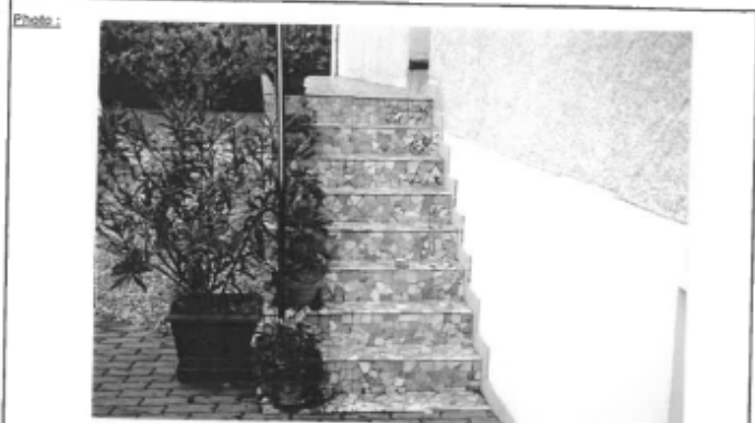
Escalier - seuil d'entrée au n°7 rue de Bracon
