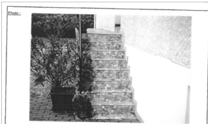
Escalier - seuil d'entrée du n°7 rue de Bracon
