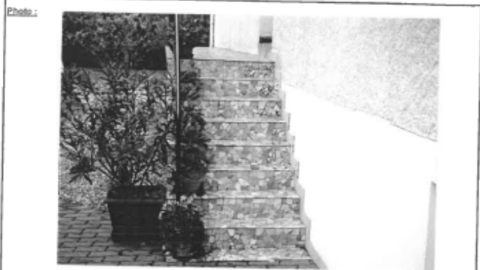
Escalier - seuil d'entrée au n°7 rue de Bracon
