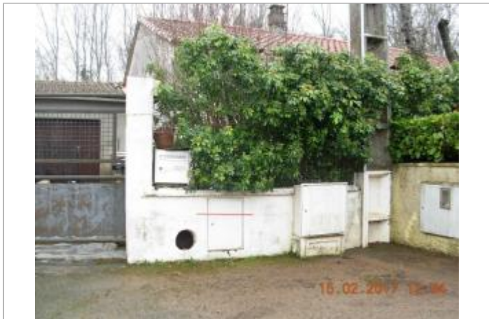
Mur de clôture
