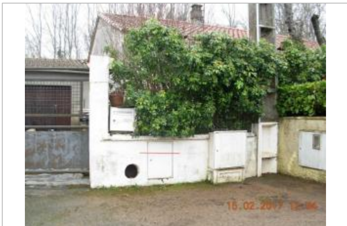
Mur de clôture
