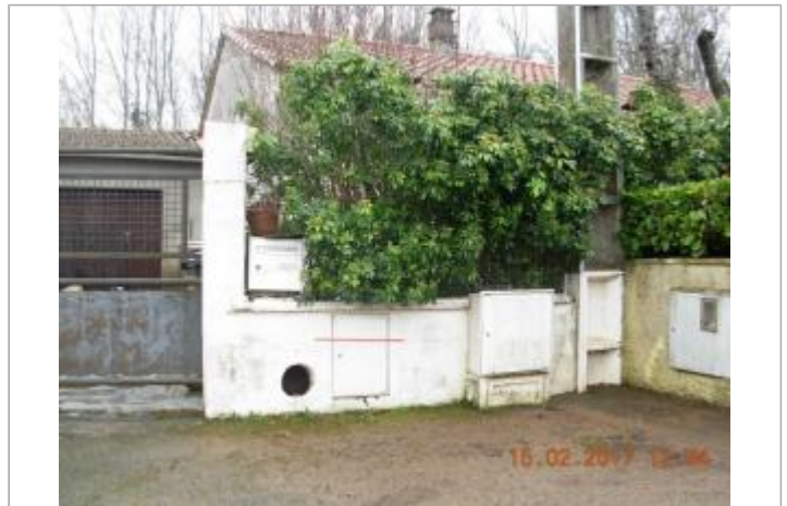
Mur de clôture
