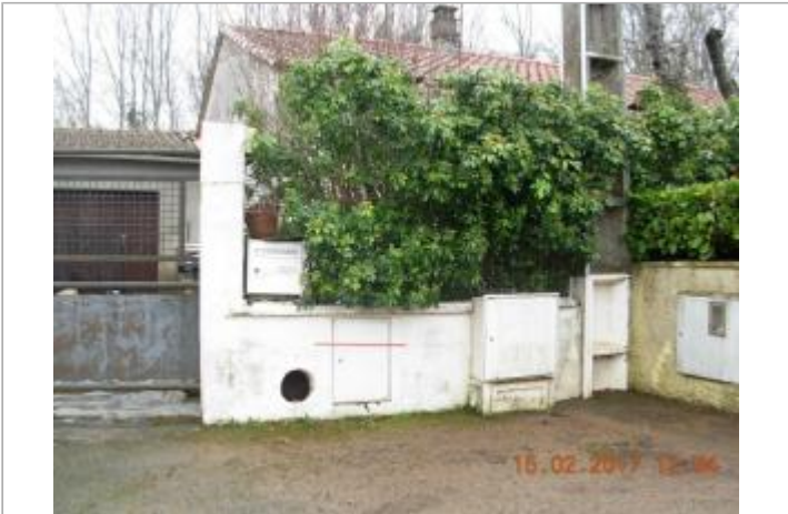
Mur de clôture
