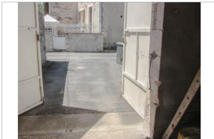
Grange du n°3 rue du port
