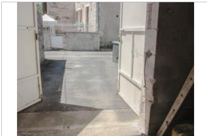
Grange du n°3 rue du port
