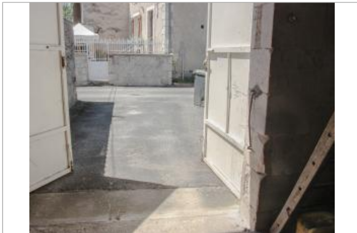
Grange du n°3 rue du port
