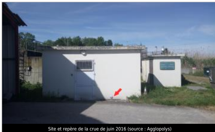
Site et repère de la crue de juin 2016 (source : Agglopolys)
