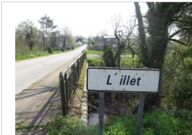
Vue du pont de la RD 25
