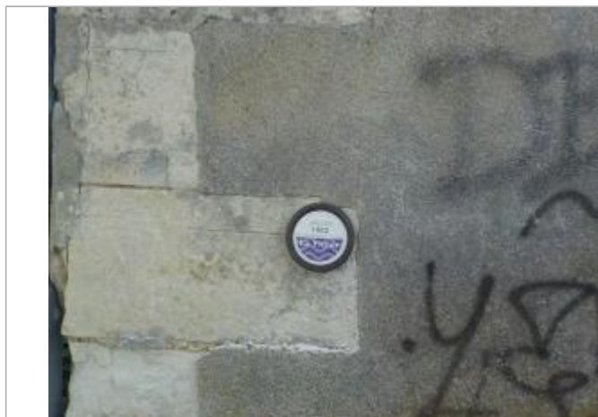
Photos du repère CHAT03-R. Source : 3DI
