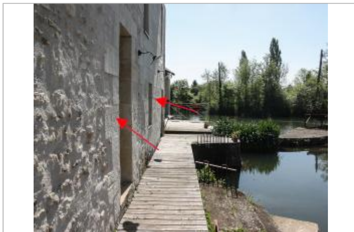
Façade amont - moulin de Souhé
