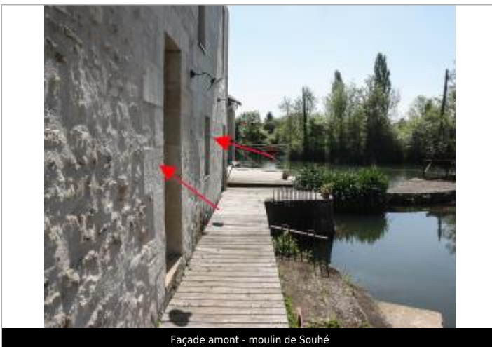
Façade amont - moulin de Souhé
