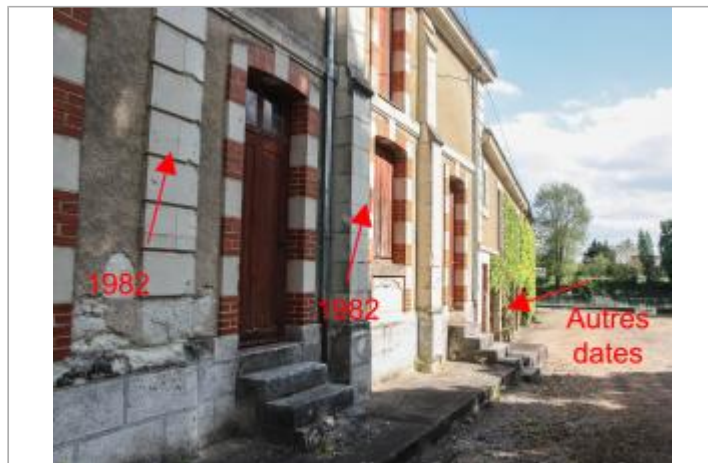
Marques sur bâtiment annexe près du moulin des Bordes
