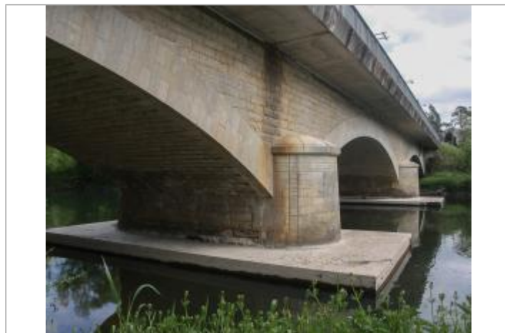
Pile du pont à Domine - rive gauche
