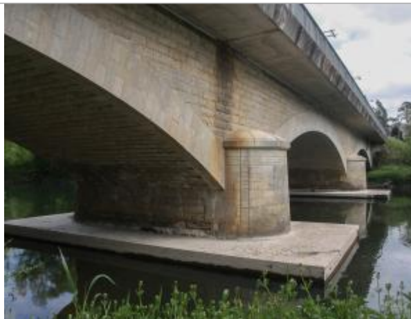
Pile du pont à Domine - rive gauche
