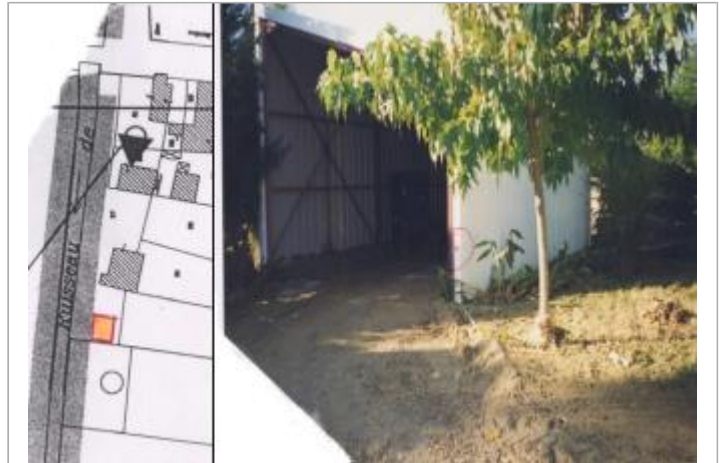
Encadrement métallique de hangar
