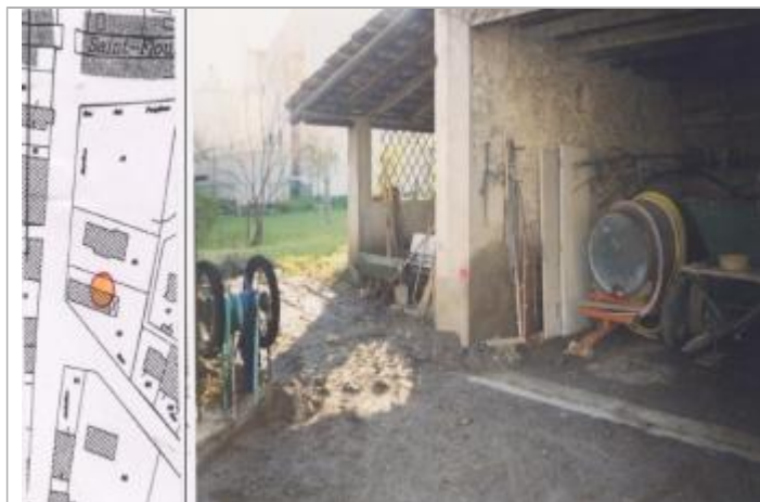
mur - pilier gauche entrée du bâtiment
