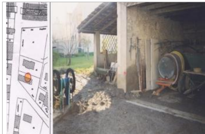
mur - pilier gauche entrée du bâtiment
