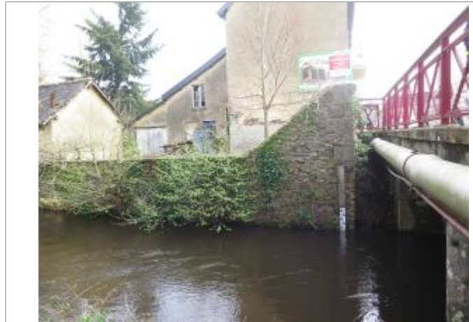
Echelle limnimétrique dans le bourg de Montreuil sur Ille
