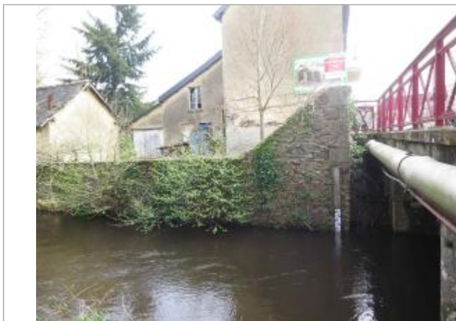
Echelle limnimétrique dans le bourg de Montreuil sur Ille
