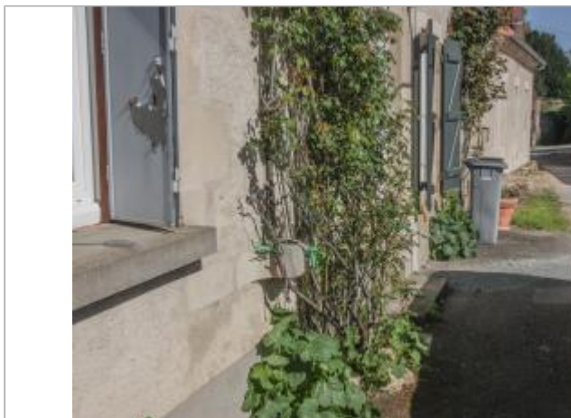
Site au n°6 impasse du moulin
