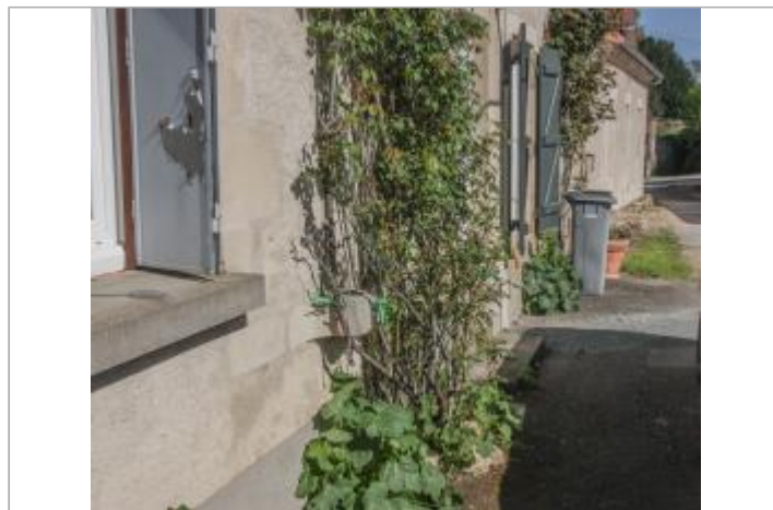
Site au n°6 impasse du moulin
