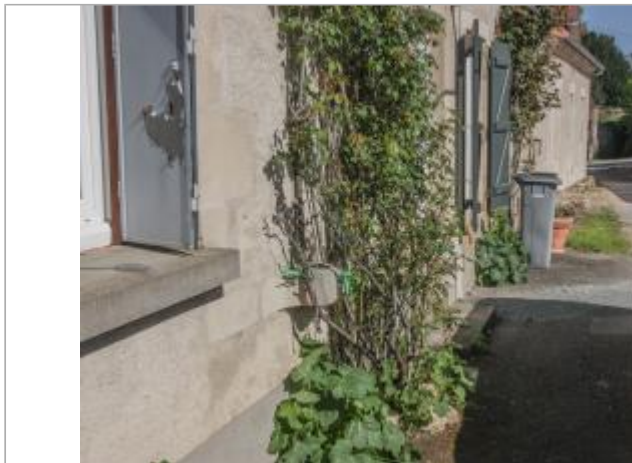
Site au n°6 impasse du moulin
